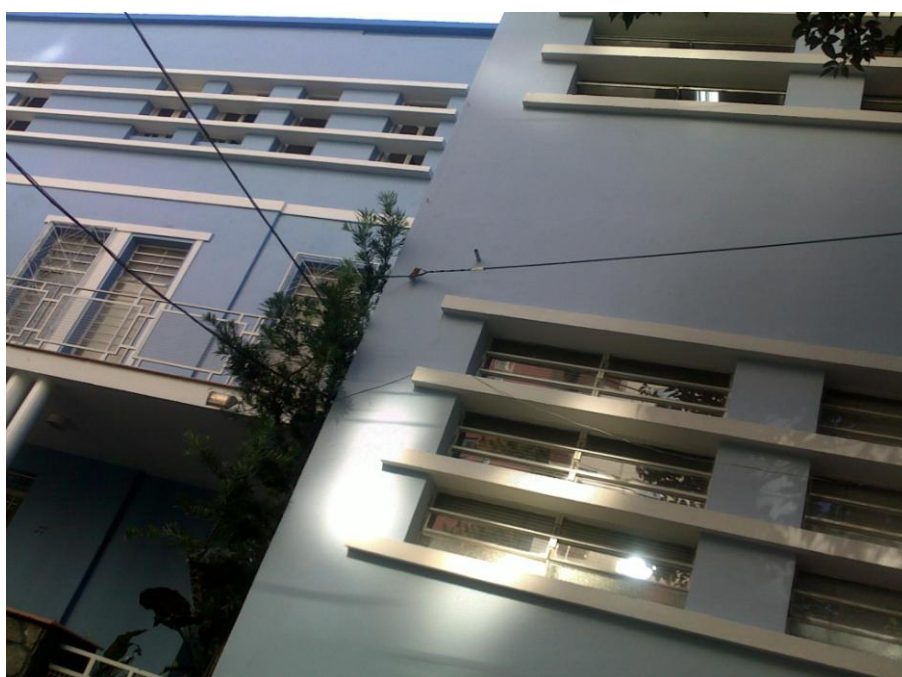
Foto 02: Detalhe da fachada da Escola Vir a Ser Fonte: Arquivo da autora
