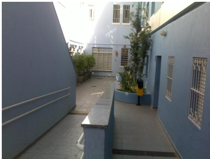
Foto 09: Detalhe da parte interna do prédio I Fonte: arquivo da autora
