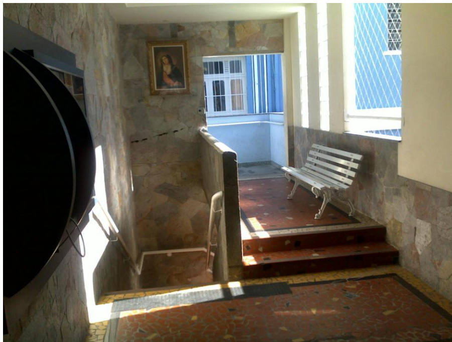
Foto 08: Detalhe da conexão entre o prédio I e o prédio II Fonte: Arquivo da autora.
