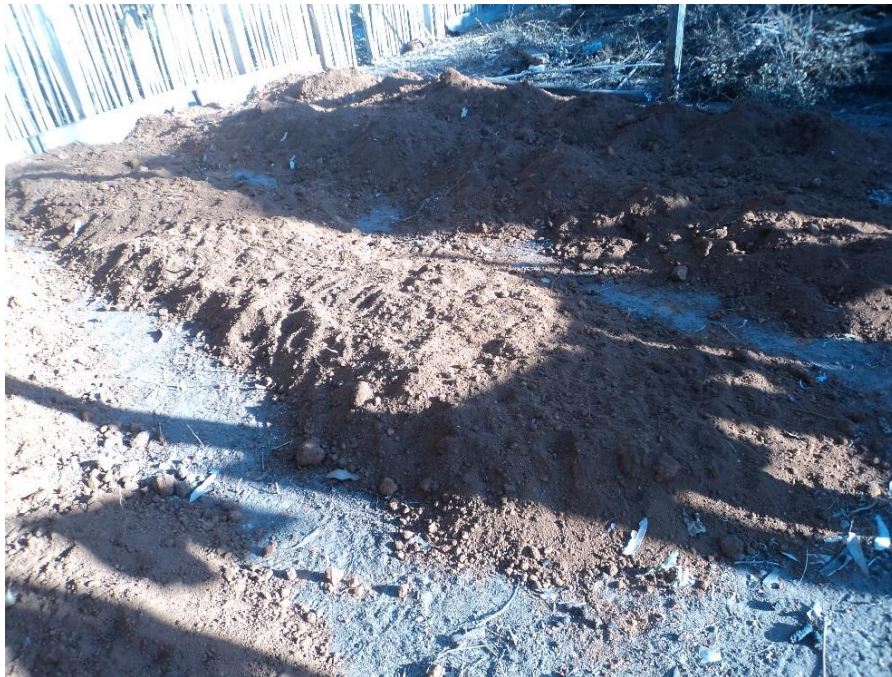
Figura 3: Construção dos canteiros
