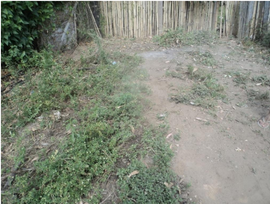
Figura 2: Limpeza do terreno
