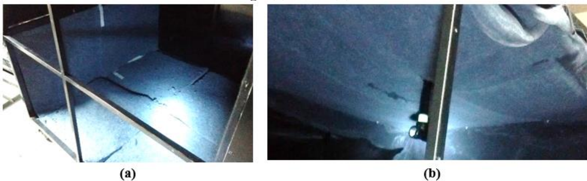
Figura 34 – Aplicação dos isolamentos porosos na carroceria: pavimento e parede corta fogo (a) e teto (b).
